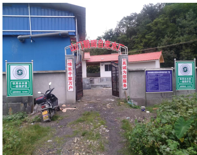
二取水点现有净水厂房
