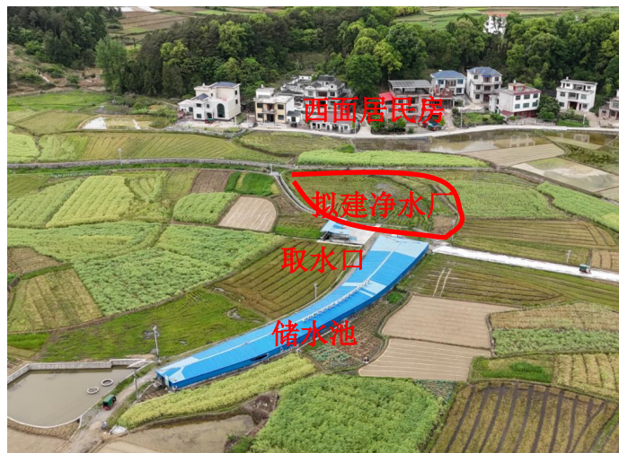
一取水点拟建净水厂周边环境
