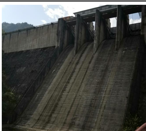
大圳水库-外坡中、右
