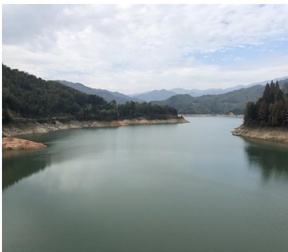
大圳水库-上游库区
