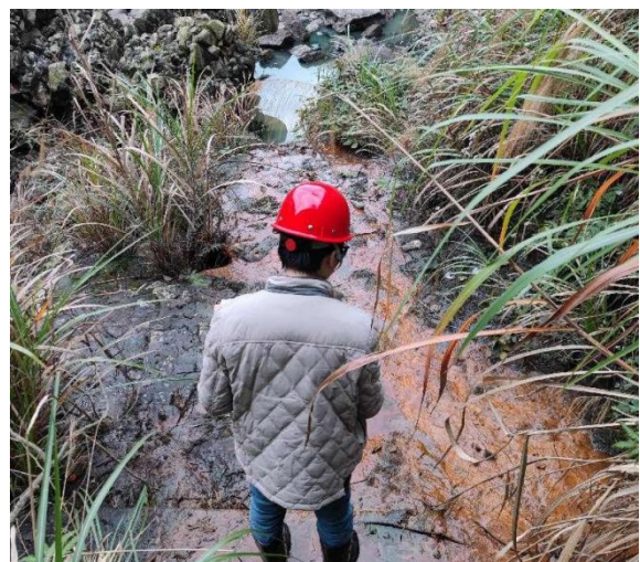
大圳水库-放空底孔
