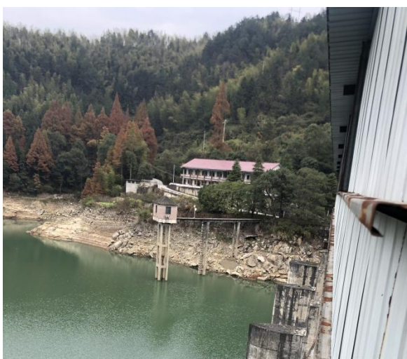
大圳水库-左岸
