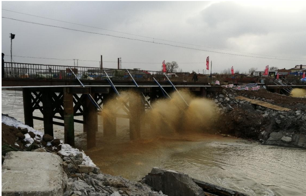
图23 多管加药现场照片
