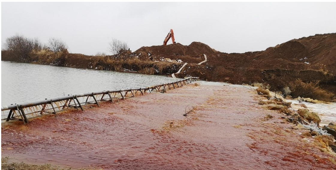
图22 穿孔加药管现场照片
