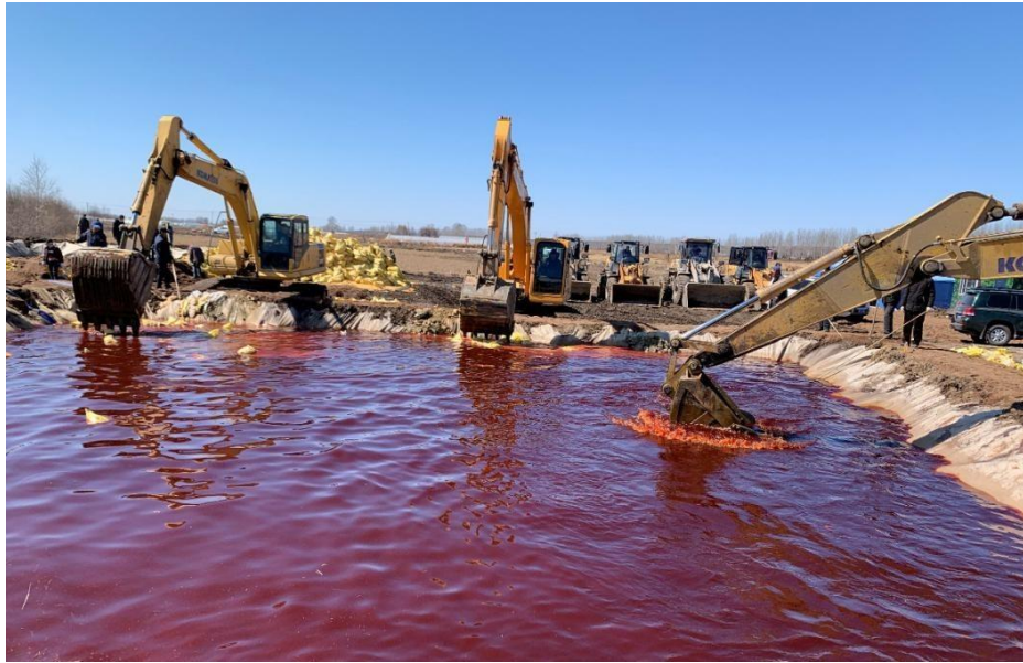
图20 溶药池现场照片
