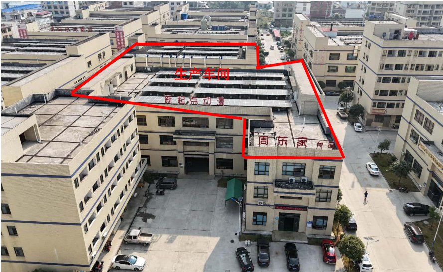
项目厂房航拍及周边环境
