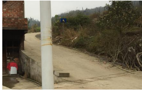
局部路段视距不良
