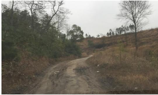
道路破损严重
