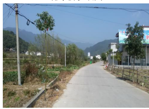
排水防护措施缺失
