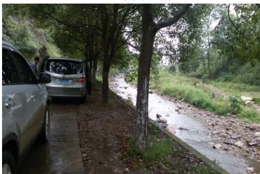
棠溪河提档墙
