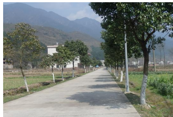
现有公路两侧行道树及简易排水沟
