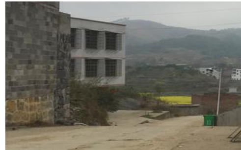
局部路段纵坡较大
